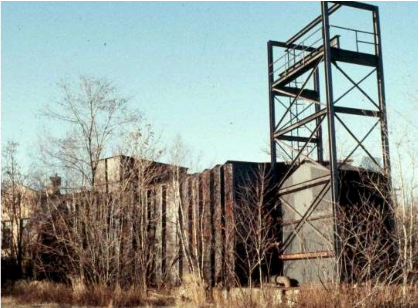
The fan house, 1984.
